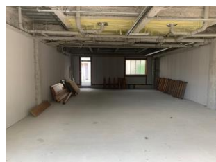
(工事前のスケルトン状態)
